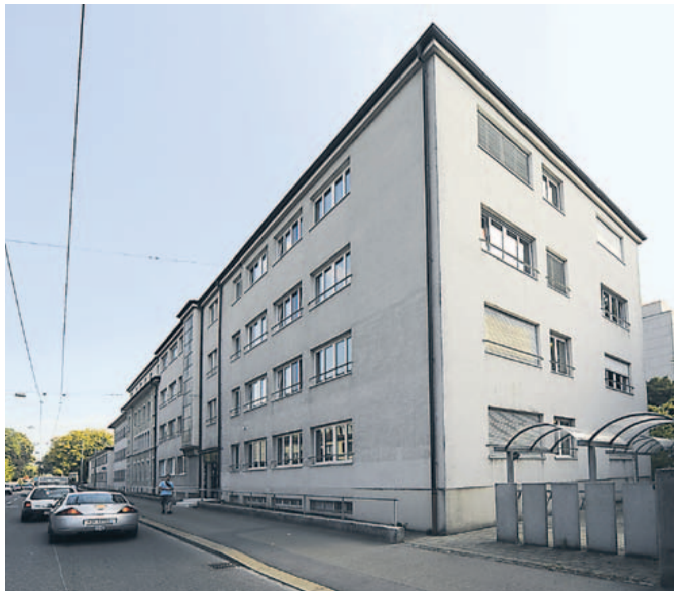
Das neue Studentenwohnheim an der St.-Galler-Strasse wird erst nächste Woche eingeweiht – doch es ist bereits ausgebucht. Bild: hd
